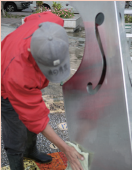
不鏽鋼基本保養程序為「風乾——擦拭金屬保養油」，圖為作品《福星高照》於99年12月之保養作業。
